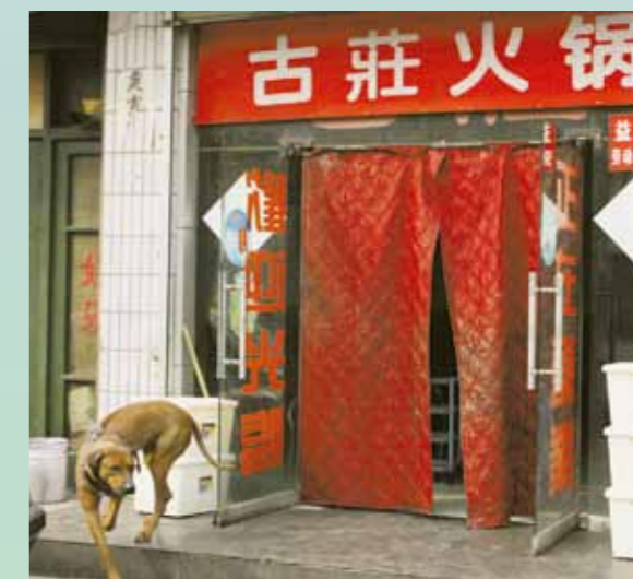
Die durchwegs schlechte Isolierung gleicht man wie hier mit dicken Decken vor den Türen aus.
